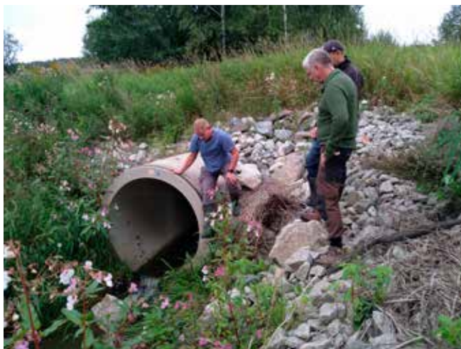
Morten Pettersen, Andreas Torbjørnsen og Kurt Magnussen studerer røret som stopper ørretvandring i Heiabekken, Skjeberg
