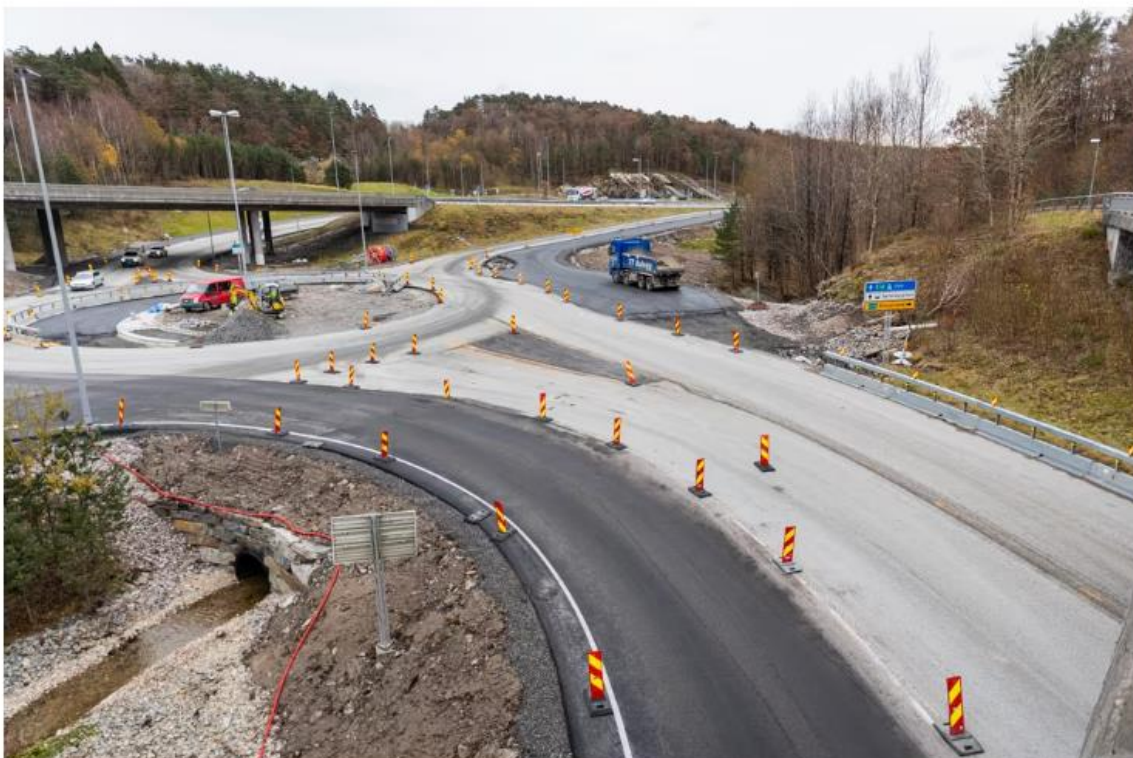
Her ses den nye rundkjøringen ved E18 i Timeneskrysset. Bekken passerer nå under veien, uten at sjørreten blir hindret. Foto: Lena Lislevand
