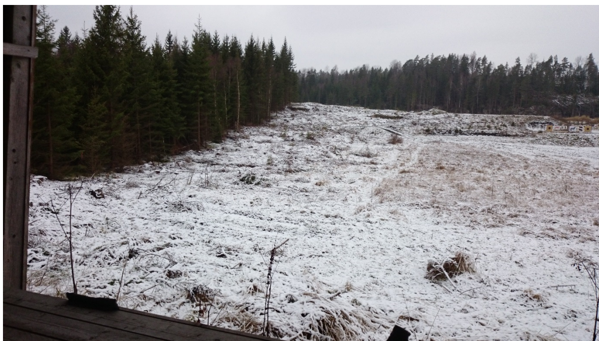
Ålerudmyra skytebane under ombygging. Foto: Sigurd Agnalt.
