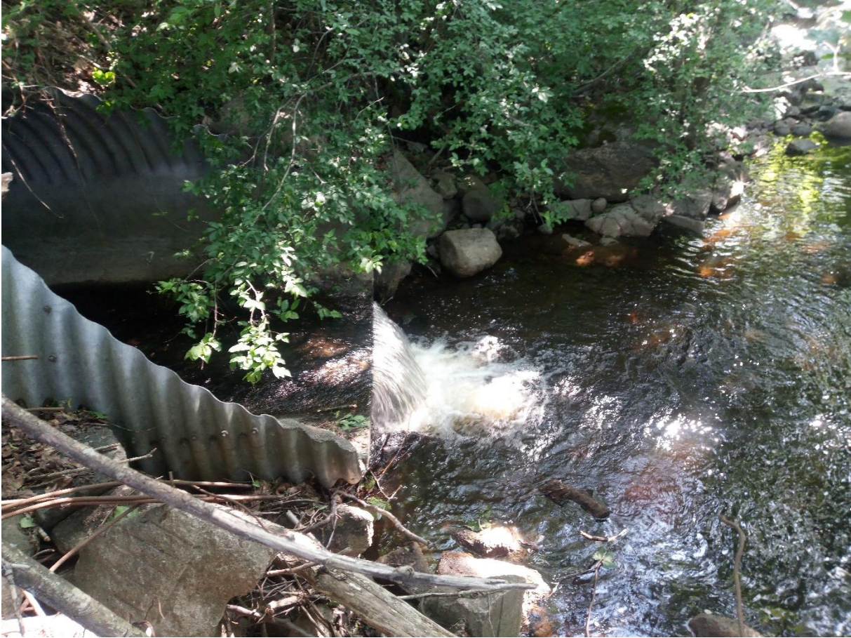
Bilde 1. Utløpet av betongkulvert under FV 281, 6. juni 2024.
