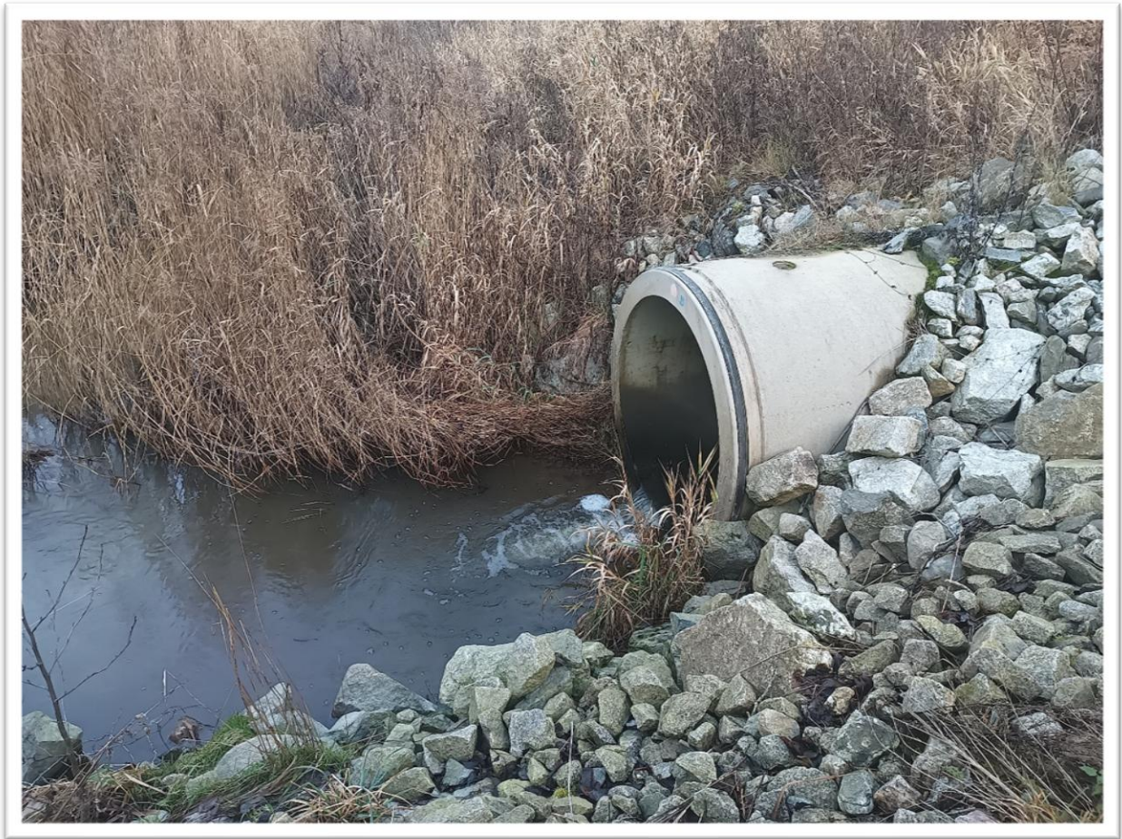
Bilde 1. Kulvert fra Heiabekken.
