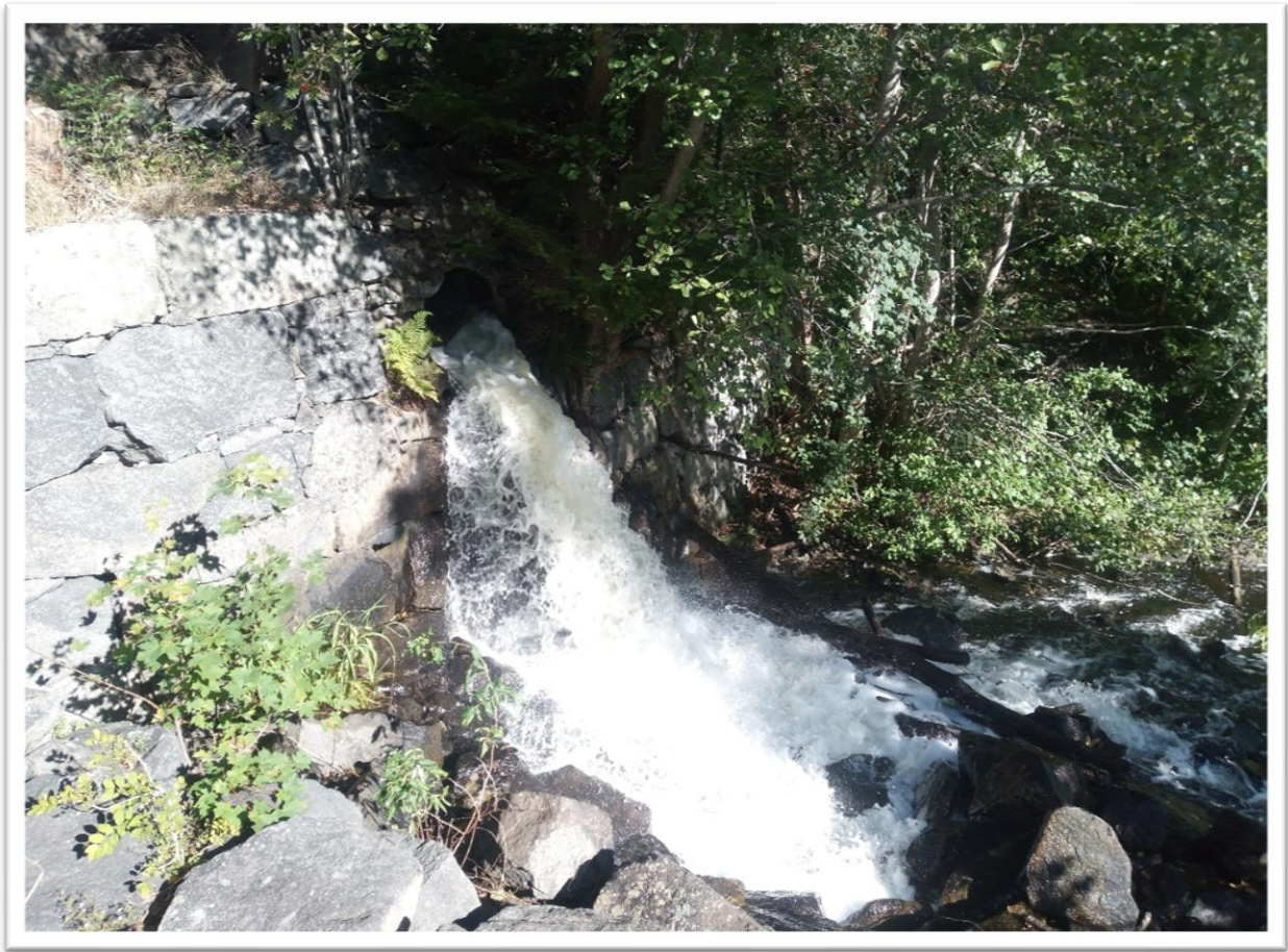
Bilde 1. Utløpet av Torpevannet, gjennom en spalte i demningen.
