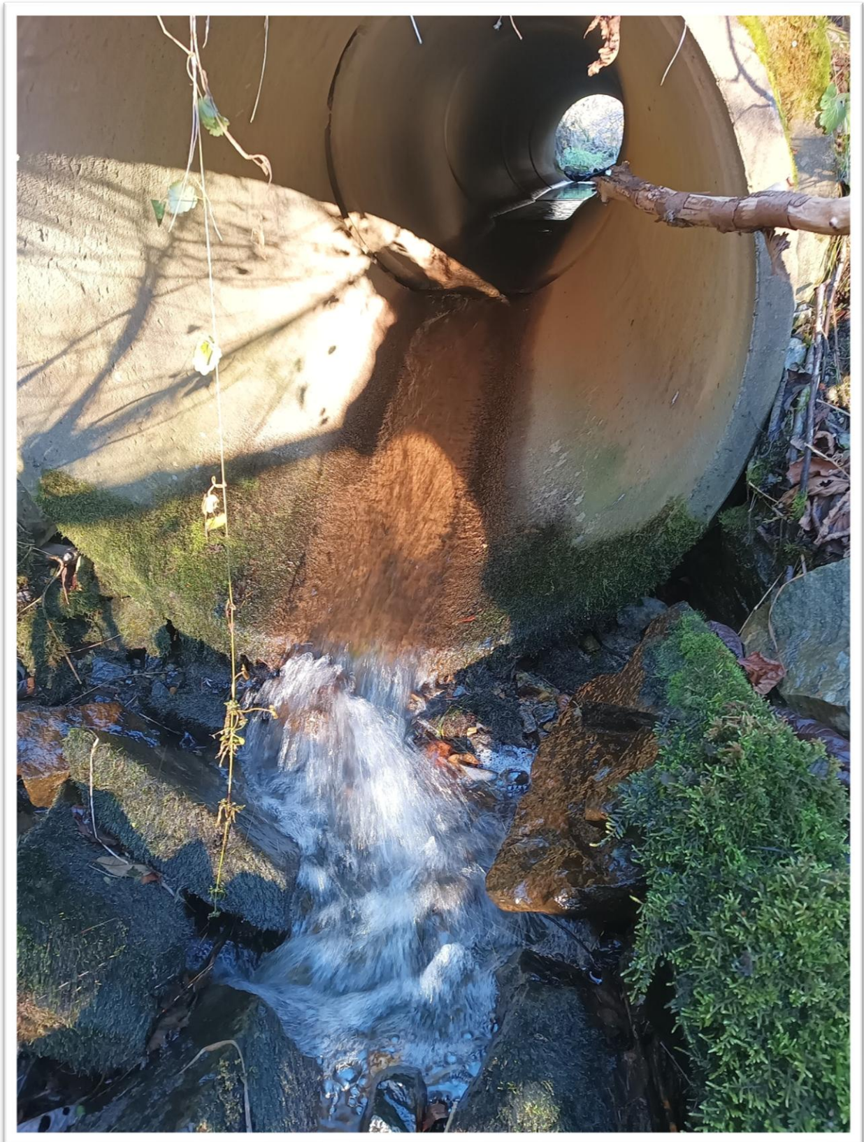
Bilde 1. Kulvert under vei mot Bamble prestegård.
