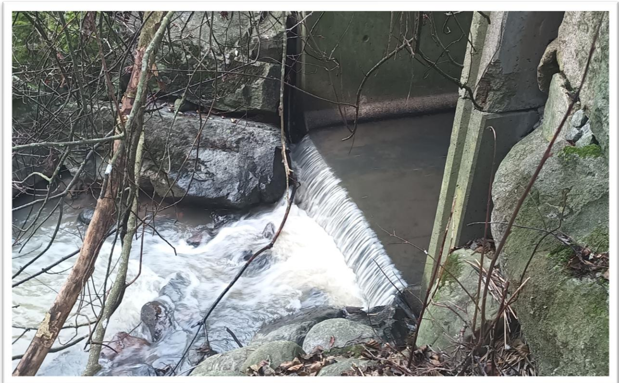
Bilde 2. Betongsåle under bro ved Nålumveien.
