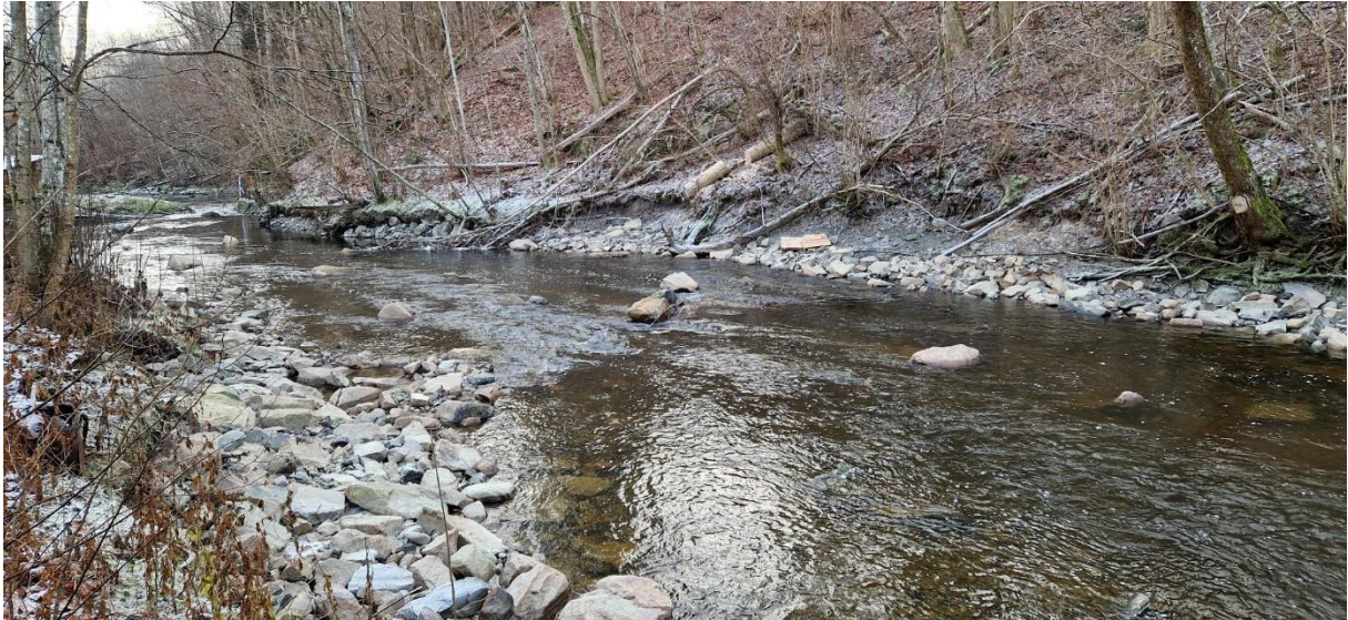
Prosj.område 2 nedre del, med lave terskler, erosjonssikring og storstein.
