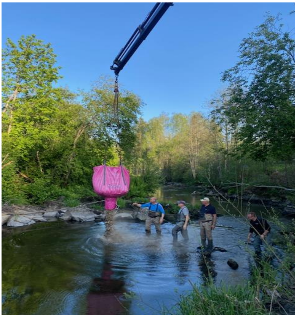
Fra utlegging i prosjekt område 3 Ølstad-Krokodden
