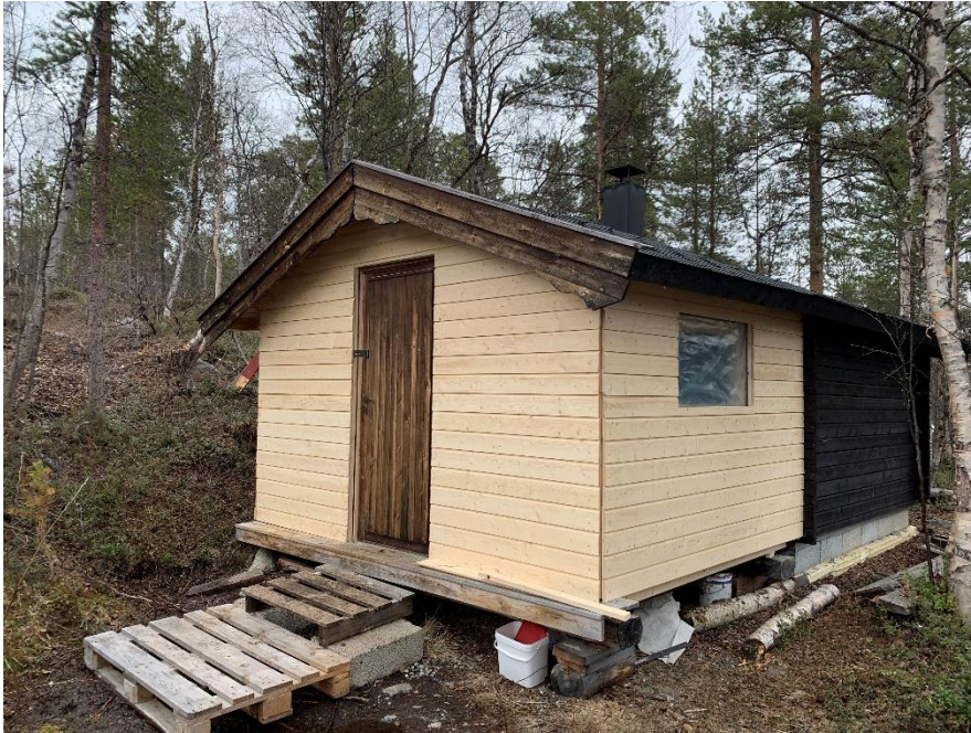
Det er montert ny dør og vindu etter bildet er tatt.
