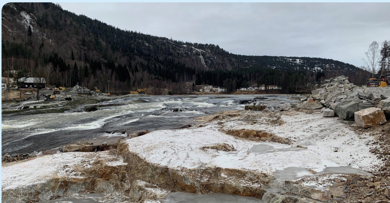
Fangdam vest ble etablert for å lede Otra over på østsiden av elveleiet slik at flomløp kunne etableres på nedsiden av fangdammen. Kraftverket skal etableres på østsiden av elva (til høyre på bildet). Foto: Svein Haugland, Agder Energi.
