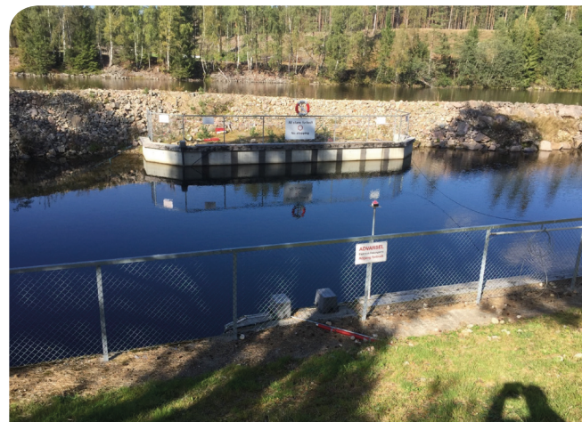
Elektrisk fiskesperre ved Kjeldal sluser ble bygget og satt i drift i 2012. Formålet er å hindre gjedde i å vandre videre oppstrøms i Telemarkskanalen. Foto: Bjørn Erik Lauritzen.
