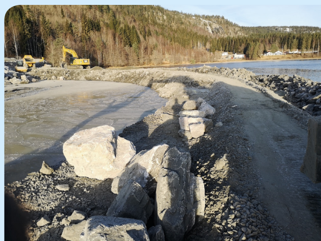
Fangdammen er bygget opp av løsmasser med ulike egenskaper og funksjoner. Plastring, støttefylling, filter-sone og tettesone som vist på bildet skal samlet sørge for en tett og sikker dam. Foto: Lars Gunnar Jansen, Agder Energi.
