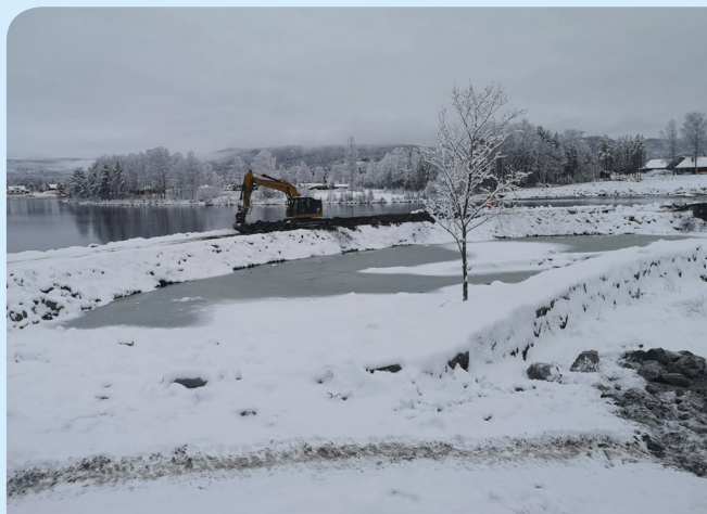
Etablering av fangdam vest pågikk døgntilnærmet kontinuerlig over flere dager første uken i januar. Fangdammen er ca. 150 m lang og ca. 6,8 m høy i dypeste snitt. Foto: Lars Gunnar Jansen, Agder Energi.
