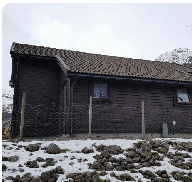
Kalkingsanlegget ved Lyse. Her er det tilrettelagt også for parkering for fotturister og fiskere, og toalettfasiliteter.
