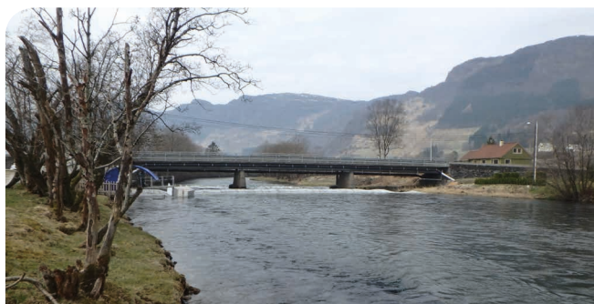
Havforskningsinstituttets fiskefelle i Etneelva. Fella består av flyterister som dekker hele elvas bredde, med et fangstkammer mot land (sees til venstre i bildet). Det er denne type felle som er mest aktuell til bruk i elver til fangst av pikkellaks.
