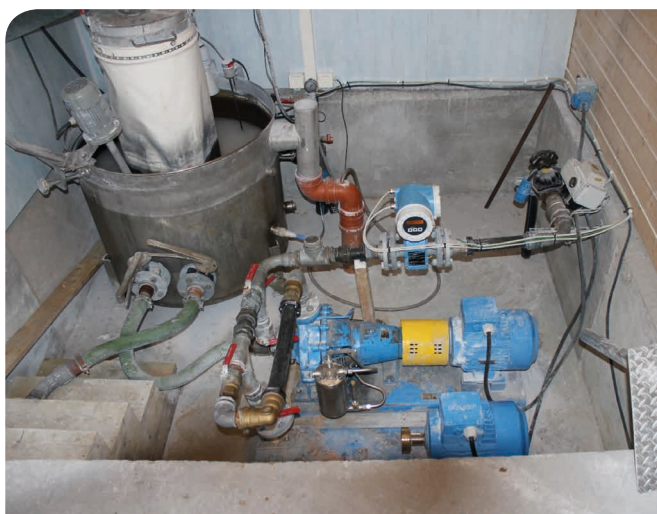
Det var denne pumpa (blå med gult felt, i nedre, midtre del av bildet) som stoppet i vinter.
