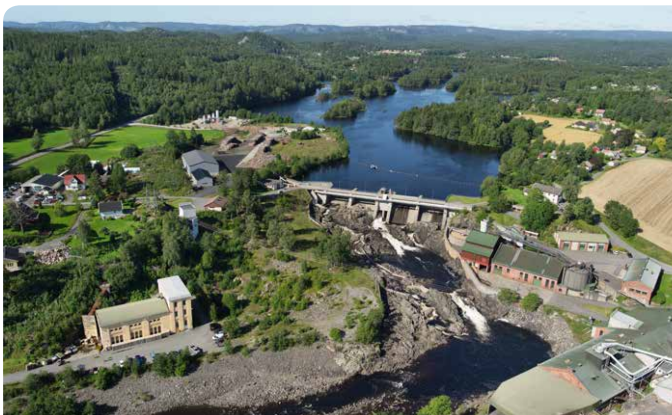
Rygene dam. Oversiktsbilde med inntaksmagasinet til Rygene kraftverk i Nidelva. Foto: Anders Martinsen/Agder Energi.
