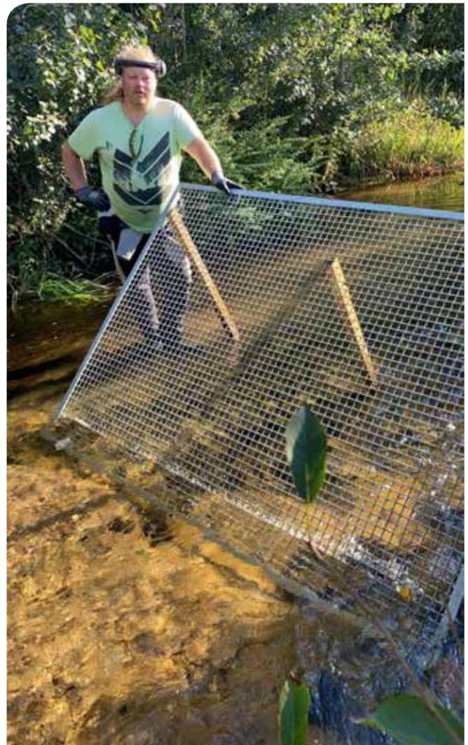
Roar Eik under restaureringsarbeid i Råna i Hellvikvassdraget. Foto: Trine Salvesen Røyneberg.
