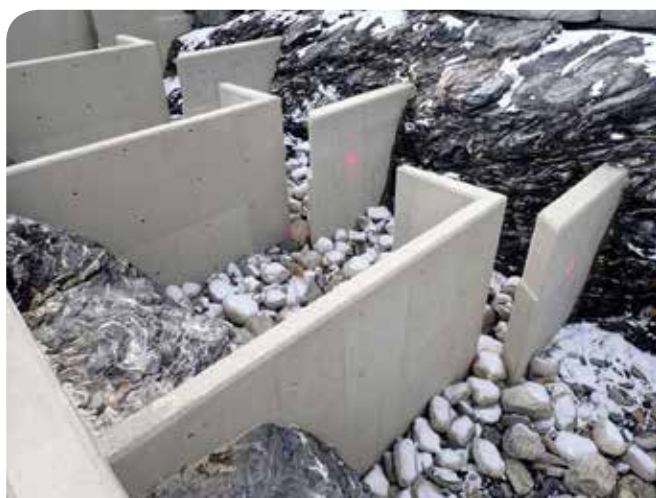
Spaltetrappen på Palmafoss med de karakteristiske spaltene, deflektorene og et gjennomgående bunnsstrat. Foto: Ulrich Pulg, NORCE LFI.
