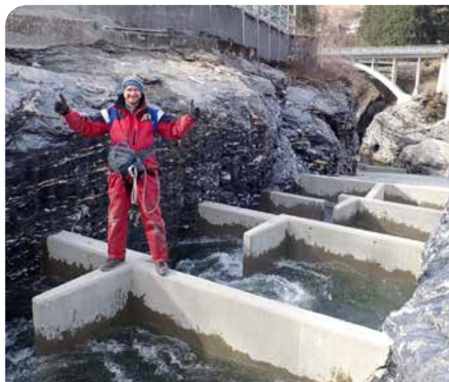
En fornøyd prisvinner, forsker Ulrich Pulg fra NORCE LFI, på den nye fisketrappa ved Palmafossen kraftverk. Dette er ei såkalt spaltetrapp, som gjør opp- og nedvandring lettere for fisk enn de tradisjonelle kulpetrappene. Foto: NORCE LFI.
