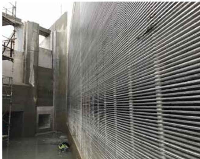
Finmasket varegrind med overflate og bunnløke i bakgrunnen. Foto: Ulrich Pulg, NORCE LFI
