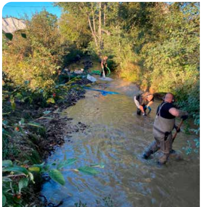
Roar Eik i elva i full gang med å spyle finsediment nedover elven. Man tar vare på de grovere morenemassene som ligger igjen, og finsedimentet lenger ned blir tatt bort med gravemaskin. Foto: Trine Salvesen Røyneberg.
