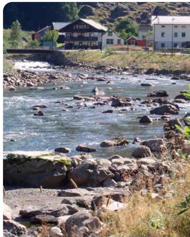
Miljøtilpasset erosjonssikring med spirende kantvegetasjon i Flåmselva, Vestland fylke. Foto: Ulrich Pulg, NORCE LFI.
