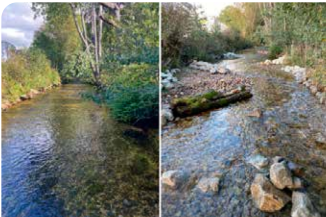
Et annet parti av Råna før og etter restaurering. Her er elveleiet lagt i svinger, og det er plassert ut større steiner som skjul. Foto: Trine Salvesen Røyneberg
