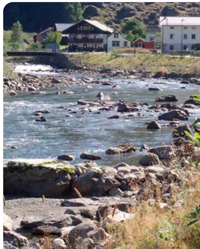
Miljøtilpasset erosjonssikring med spirende kantvegetasjon i Flåmselva, Vestland fylke. Foto: Ulrich Pulg, NORCE LFI.
