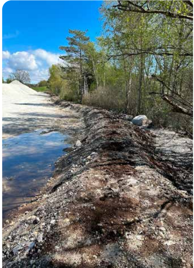
Voll for å beskytte mot framtidig grusavrenning til Råna. Foto: Trine Salvesen Røyneberg.
