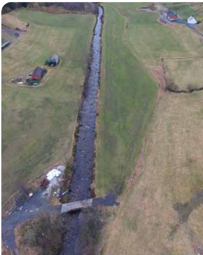
Brekkeelva, Vestland fylke. Kanalisering og utretting gir dårligere miljøforhold og øker vannets krefter når flommene blir større, og overtopper dimensjonering. Foto: Christoph Postler, NORCE LFI.
