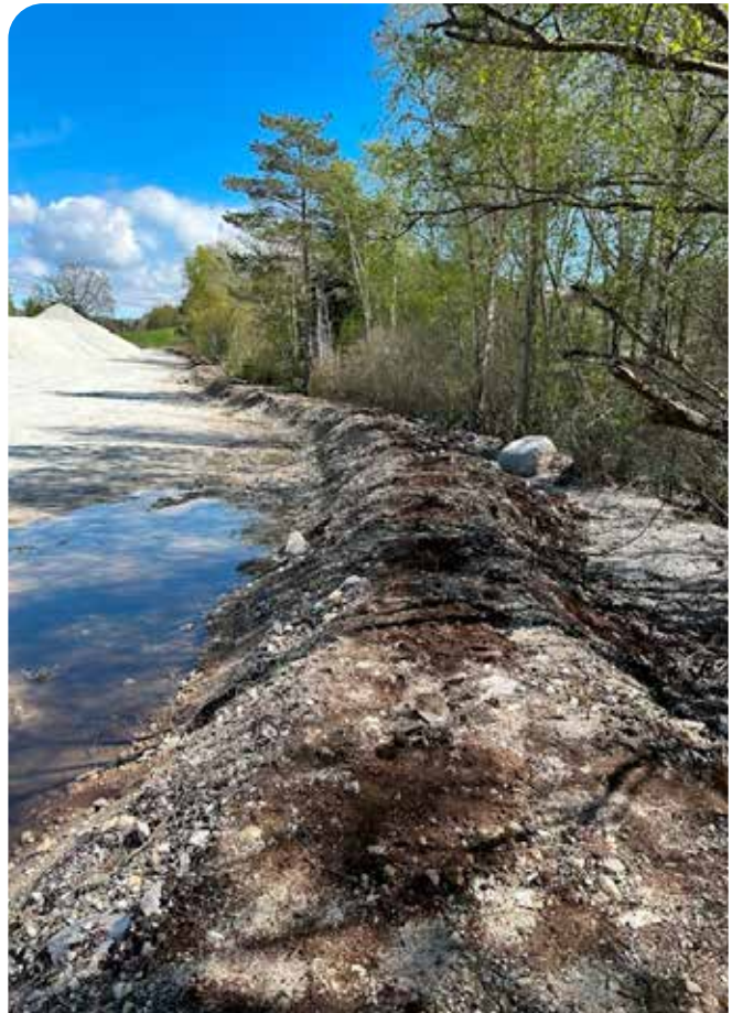
Voll for å beskytte mot framtidig grusavrenning til Råna. Foto: Trine Salvesen Røyneberg.
