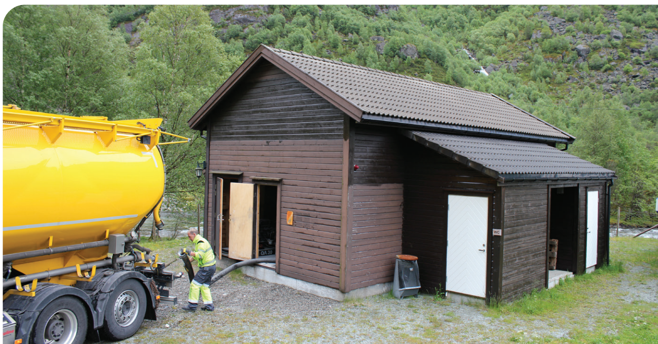
Etterfylling av kalk ved kalkdosereren i Lyse.
