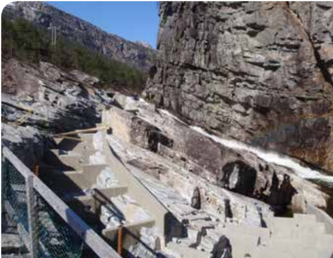
Laksetrappa i Raufossen under bygging.
