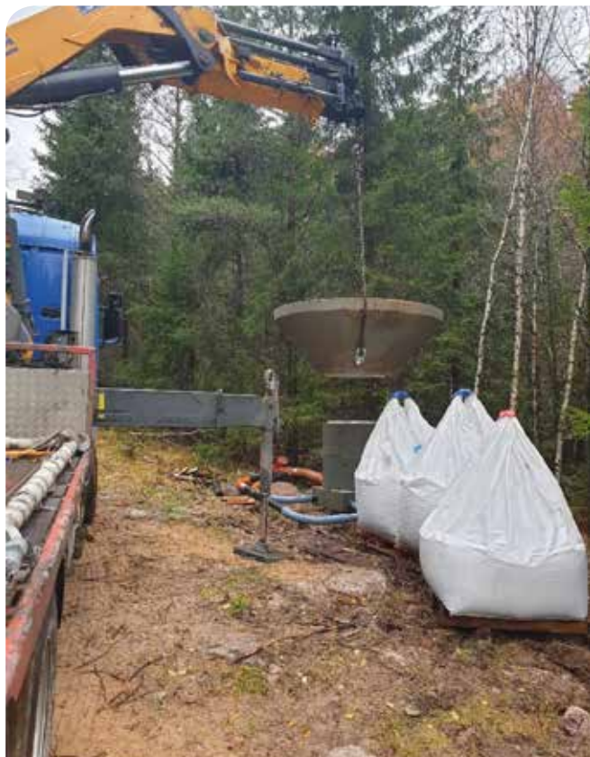
Figur 3. Fluidiseringsenhet under montering og i drift. Storsekkene inneholder kalksteinspukk av forskjellig stør- relse. \text{CaCO}_3 -konsentrasjon i pukken er > 97\% .
