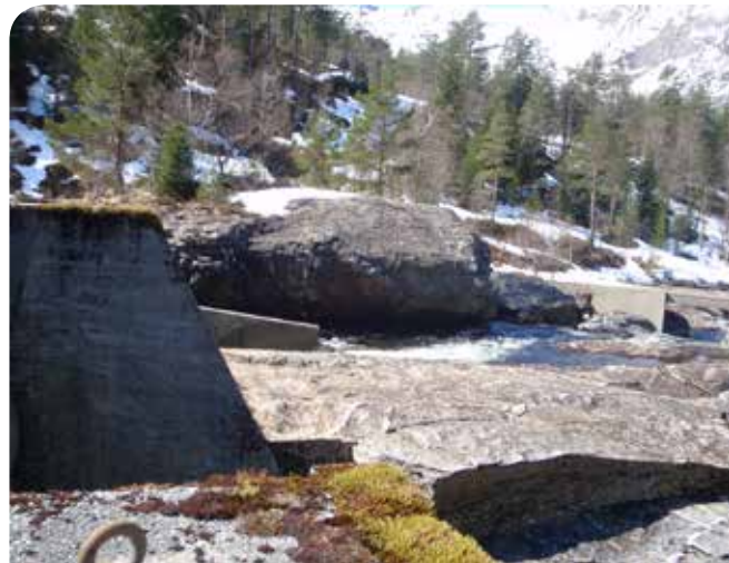
Minstevannføringen slippes herfra, fra utløpet av dammen ved Nesevatnet.
