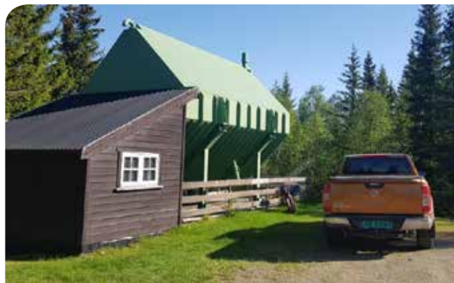
Kalkingsanlegget ved Flagstadelva. Foto: Heidi Eriksen, Statsforvalteren Innlandet.
