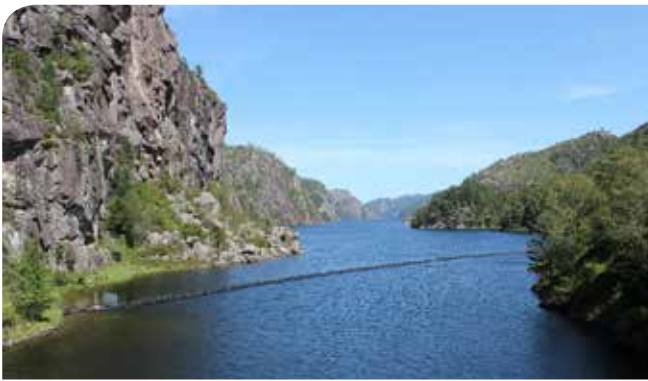
Lundevatnet. Dette er inntaksmagasinet til Åna-Sira kraftverk.
