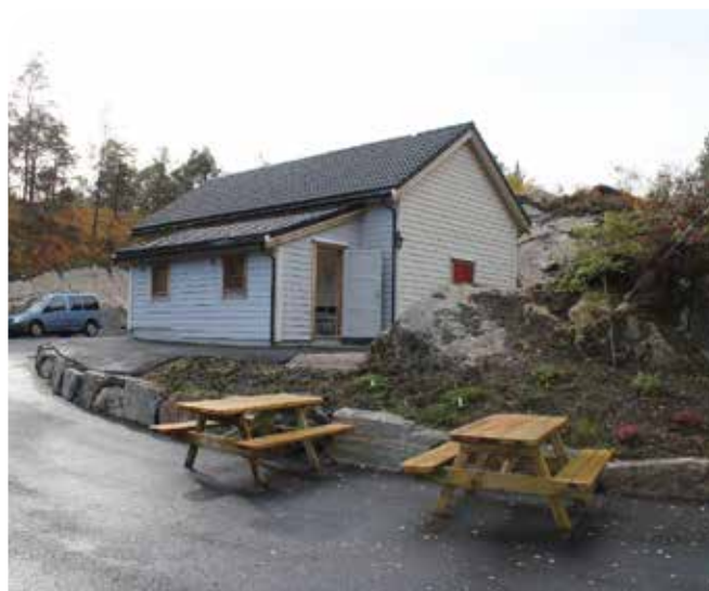
Kalkingsanlegget ved Ostavatnet, like ovenfor lakseførende strekning.
