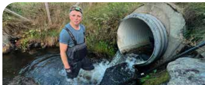
Litt tilrettelegging i kulp nedstrøms utløpet av røret, for å lette innspranget av fisk til røret.
