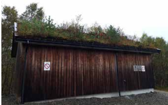
Silikatanlegget ved Storåsfoss.
