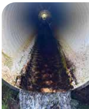
Røret før montering av fleksiterskler.
