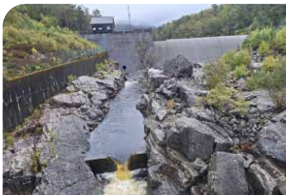
Dammen ved Storåsfossen. Herfra slippes minstevannføring hele året, målepunktet for vannslippet er spalten i terskelen i nedre billedkant. Det er her silikat tilsettes for å avsyre vannet i Jørpelandselva.
