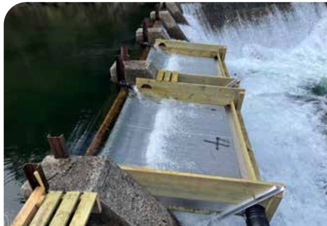
Smoltfelle (såkalt Wolffelle) på toppen av Hellandsfossen i Modalselva. Her fanges utvandrende vill laksesmolt, som deretter pit-merkes og slepes ut fjorden. Foto: Eirik Straume Normann, NORCE LFI.
