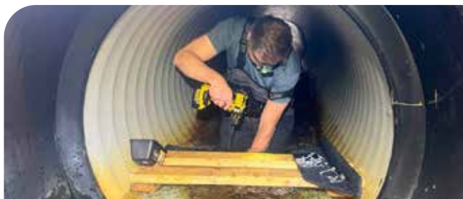
Montering av fleksiterskel inne i røret. Trange arbeidsforhold her!
