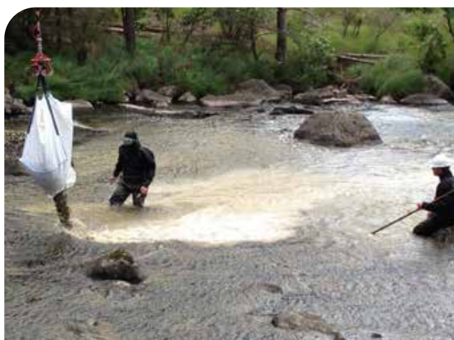
Det er en del områder på lakseførende strekning av elva som er vanskelig tilgjengelig, og her er det lagt ut gytegrus ved hjelp av helikopter. Foto: Jørpeland Kraft A/S.
