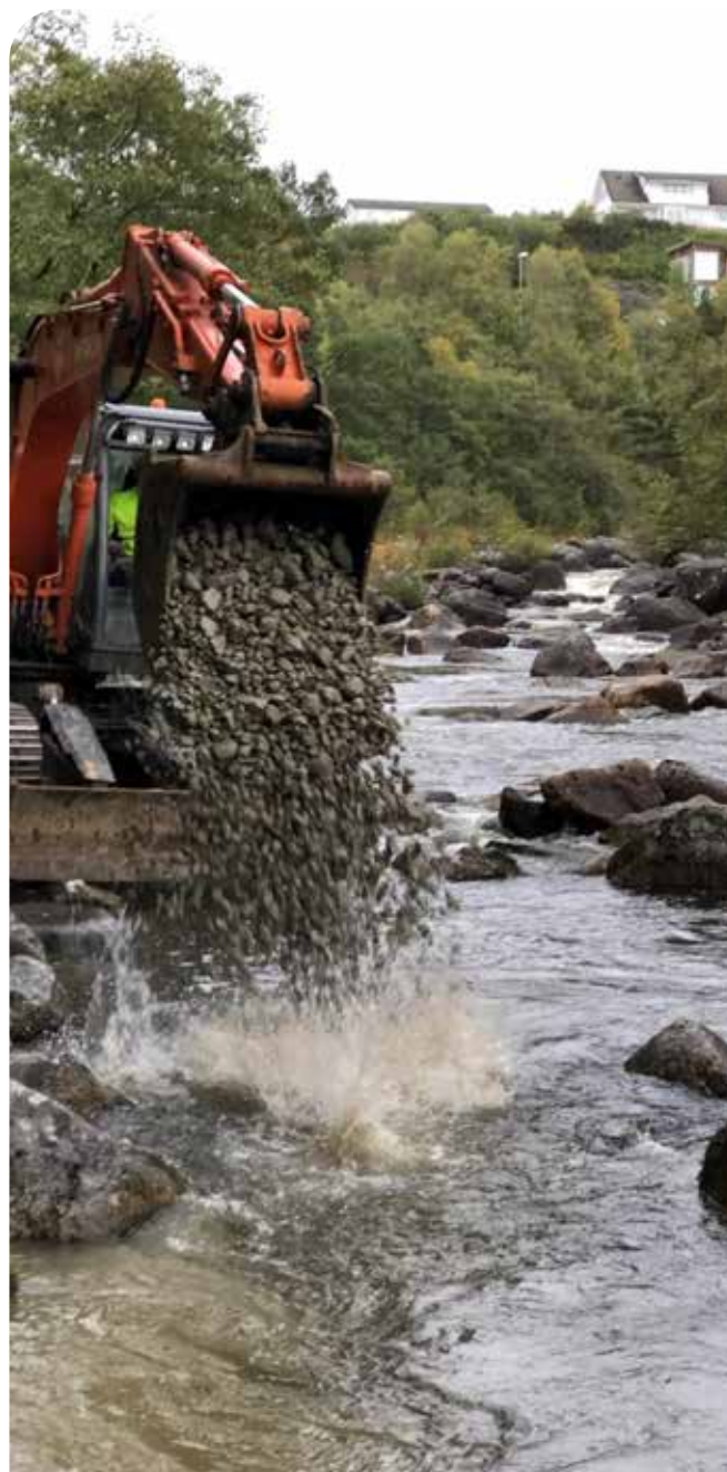
I områder mer tilgjengelig fra vei er det lagt ut gytegrus med gravemaskin. Foto: Jørpeland Kraft A/S.
