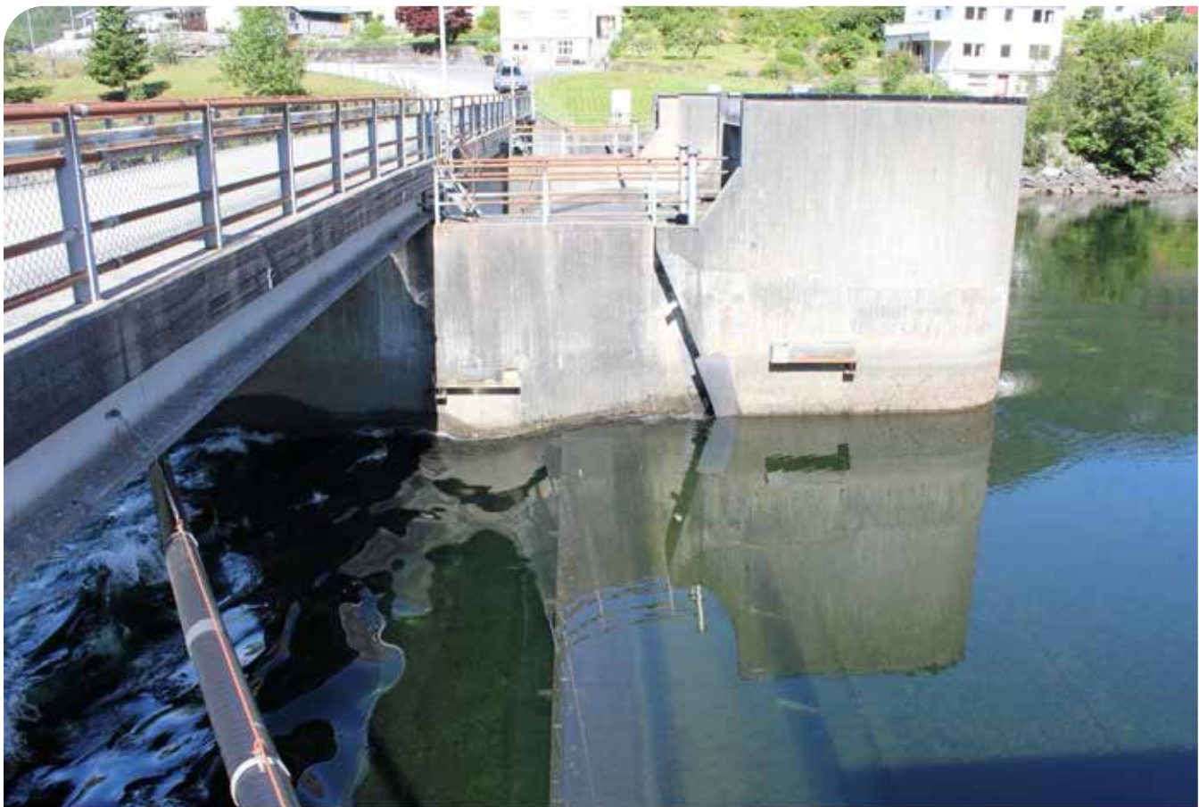
Reguleringsdammen ved Osvad. Fisketrappa er inne i betongkonstruksjonen midt i bildet. Bildet er tatt på relativt høy vannføring, 79 m 3 /s.
