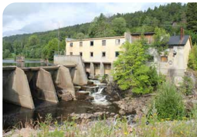
Fostveit kraftverk i Storelva. Fisketrappa ses midt i bildet.
