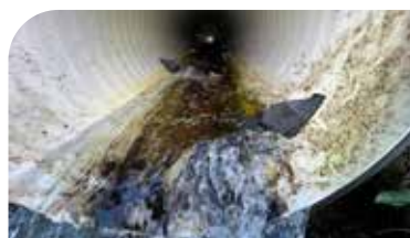
Røret etter at fleksitersklene er montert.
