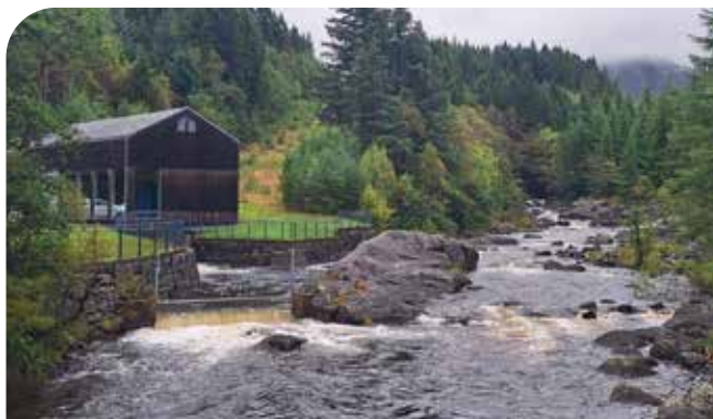
Dalen I kraftverk. Utløpet av kraftverket ses i venstre bildekant. Her er det ei fiskesperre for å hindre fisk å vandre inn i kraftverksutløpet. Laks og sjøaure kan vandre noen hundre meter opp forbi kraftverket i elva, som ses til høyre.
