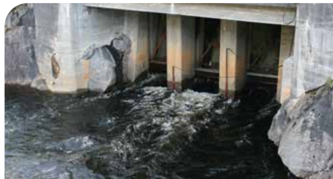
Utløpet fra Laidal kraftverk.
