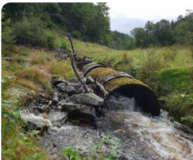
Rør eller kulverter er klassiske eksempler på vandringshindre for fisk i vassdrag.
