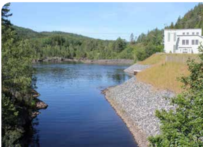
Utløpet av Frøysåna/Langsimavassdraget i Otra ved Iveland. Iveland kraftverk ses til høyre i bildet.
