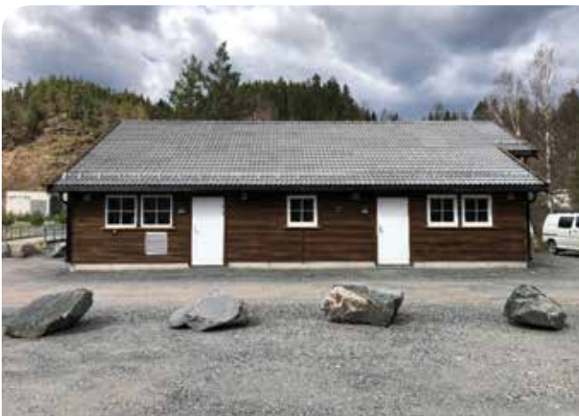
Den nye kalkdosereren ved Iveland. Foto: Terje Lysnes, Franzefoss Minerals A/S.
