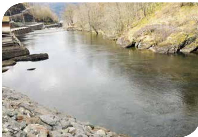
Inntaket til Tyssefossen kraftverk (i venstre bildekant). Terskelen til inntakskulpen er høy og utgjør trolig et hinder for oppvandrende laks og sjøaure. Foto: Ove Gåsdaal.
