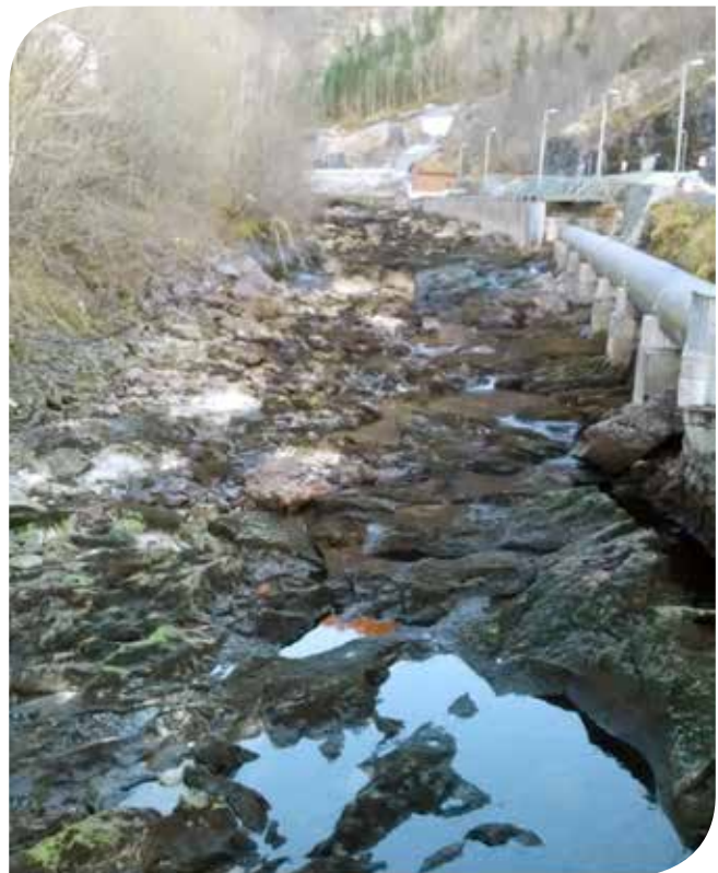
Tysseelva er regulert også på anadrom strekning i forbindelse med Tyssefossen kraftverk. Bildet over er tatt 16. april 2017 og dokumenterer en svært lav vannføring, langt under den pålagte minstevannføringen. Mobilfoto: Thor-Olav Holmefjord.
