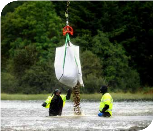
Når helikopteret hadde fått storsekken med gytegrus i riktig posisjon, skar mannskapet ute i elva hull, slik at grusen havnet på riktig sted! Foto: Jon Anders Skau, Agder Energi.
