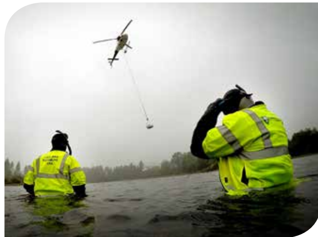
Helikopter fra Fjellfly transporterte gytegrusen i storsekk ut til mannskap på plass i elva, ved de planlagte gytefeltene. Foto: Jon Anders Skau, Agder Energi.
