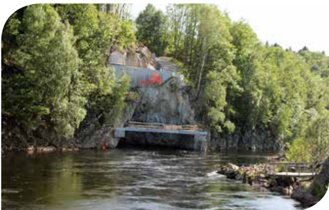
Før den elektriske fiskesperra kom på plass i 2014 var det et problem at laksen gikk inn og stilte seg i kraftverkstunnelen. Foto: Alv Arne Lyse.
