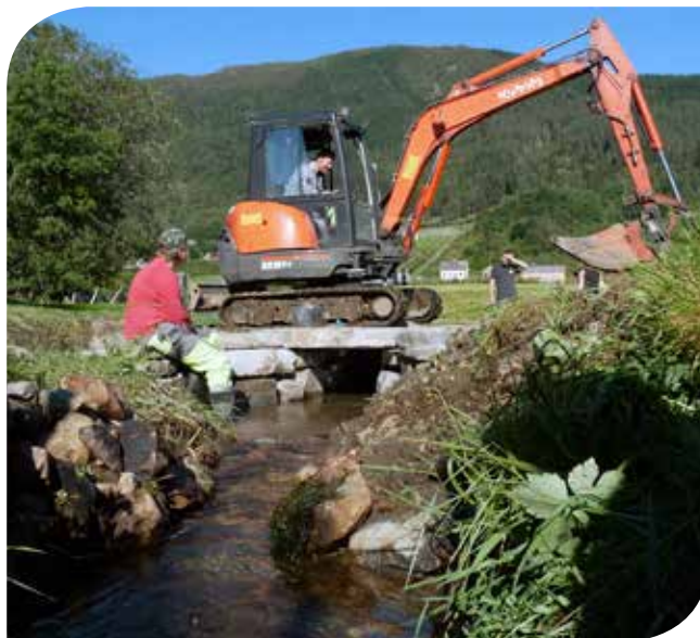
Sluttresultatet: et gammelt betongrør har blitt erstattet av ei vakker, ny steinbru. Foto: Sven-Helge Pedersen, Hardangerfjord Villfisklag.
