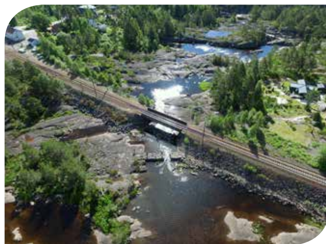
I forbindelse med jernbanebygging og tømmerfløting er det laget en mur som snevrer inn utløpet fra Gauslåfjorden. Dette gjør at det renner mindre vann i løpet ned til Laksefoss, noe som bidrar til å gjøre oppvandringsforholdene dårligere. Dronefoto: Christoph Postler, NORCE LFI.
