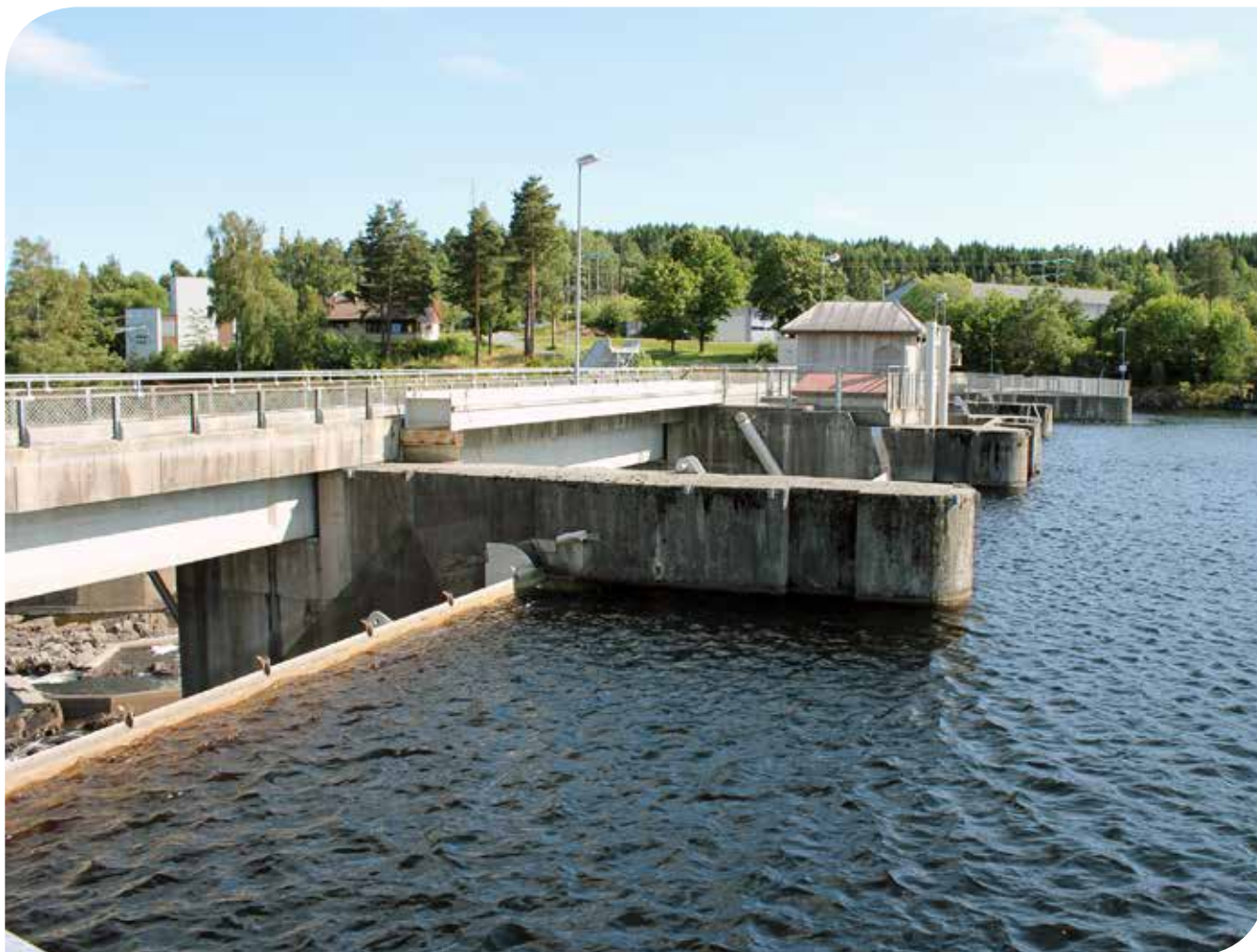
Rygene dam i Nidelva. Her arbeides det for å få til bedre nedvandringsløsninger for fisk og ål.
