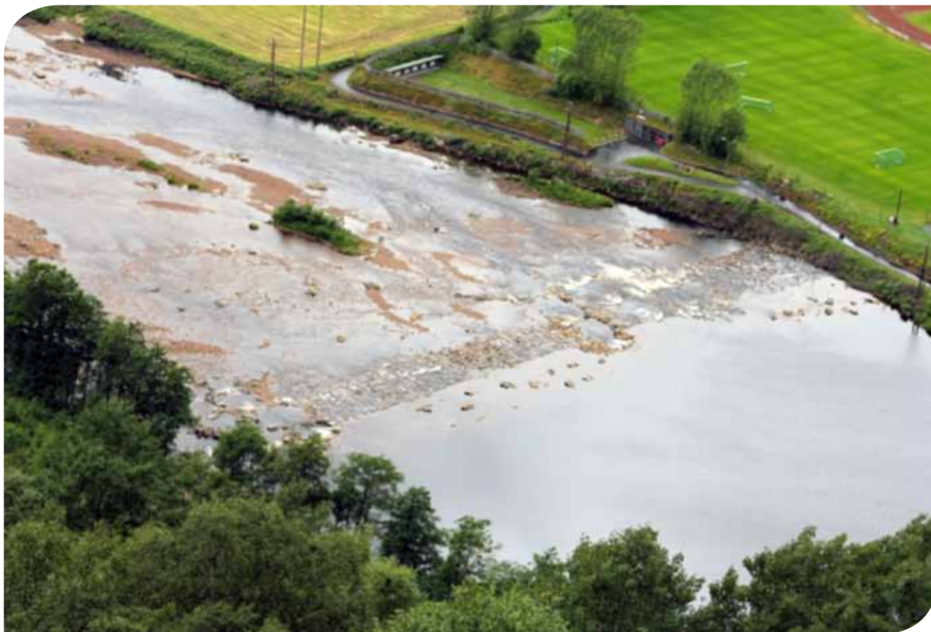
Habitatforbedringstiltak med terskel og utlagte store steiner i nedre del av Kvina. Foto: Alv Arne Lyse.
