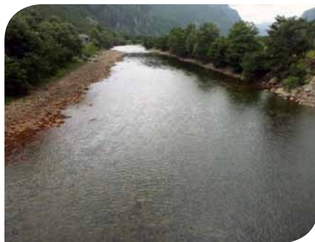
Bilde 1. Nedre del av Frafjordelva før tiltaksarbeidet begynte med grunn, homogen, trapesformet og steinsatt elveprofil med lite skjul og nesten ingen standplasser for fisk.
