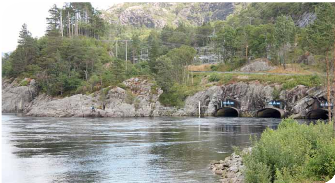
Det er store vannmengder som passerer kraftverket i Åna-Sira. Hølen der kraftverket munner ut er den viktigste fiskeplassen i vassdraget.
