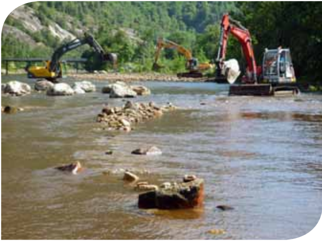
Bilde 3. Fra oppstarten av tiltaksarbeidet i 2013.
