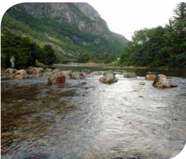
Bilde 4. Ferdig bane med spredt steinutlegging ved lav vannføring.
