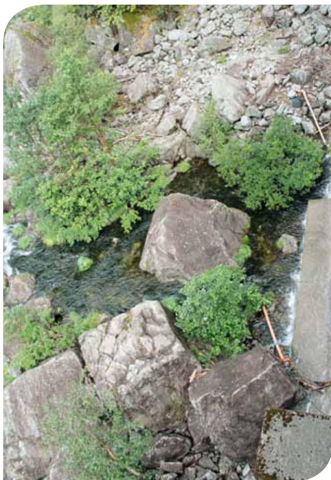
Lekkasjer i dammen ved Lundevatn gir vanligvis en «minstevannføring» på rundt 0,5–1 m 3 /s fra dammen.
