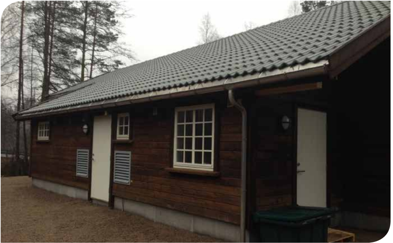
Slik ser det nye anlegget ut fra utsiden. Foto: Birgit Solberg, Fylkesmannen i Aust- og Vest-Agder.
