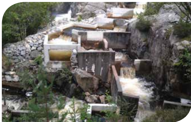
Etter ombyggingen i 2012 fungerer nå fisketrappa i Jørpelandselva utmerket. Foto: Jørpeland Kraft A/S.
