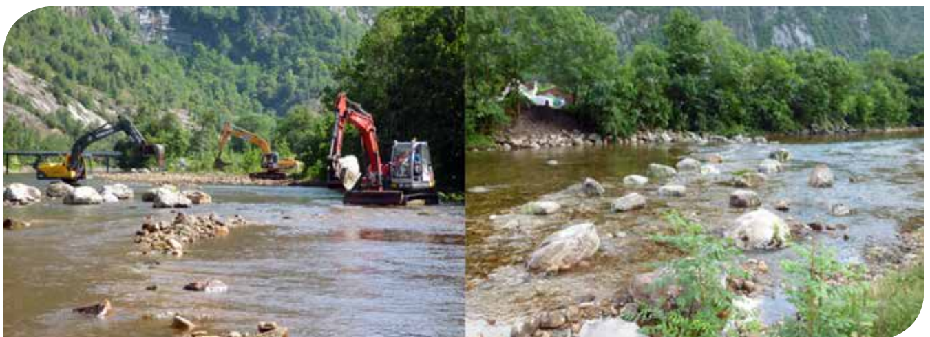
Figur 2: Bygging av oppløste buner i nedre deler av elven i 2013. I motsetning til terskler stuer de verken opp vannet eller låser elvebunnen, men sørger likevel for morfologisk variasjon, standplasser og skjul.
