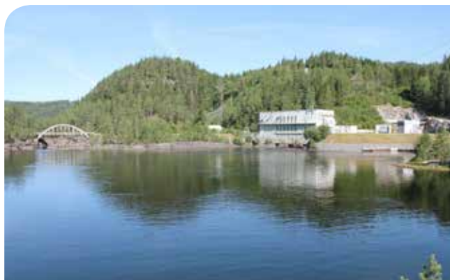
Hølen ved Iveland. Frøysåna kommer inn i fra høyre billedkant, kraftverktløpet ses omtrent midt i bildet, mens overløpet fra dam vil komme under brua til venstre i bildet.
