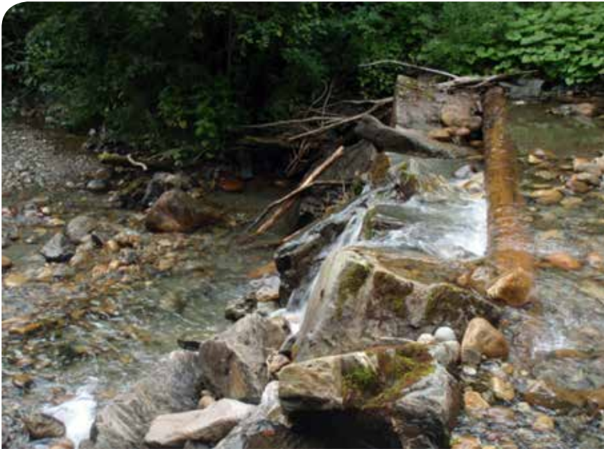
Figur 3. En av til sammen tre demninger i Kaldvella. Demningene er oppført i naturlig anadrom strekning av elva, og stopper fiskevandring. Foto: © Morten Andre Bergan.
