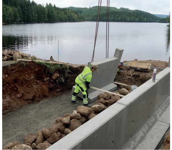
Ny spesialbestilt kulvert under skogsbilveien monteres, med «naturlig» bekkbunn.
