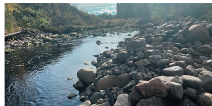
Punkt fjerning av kantvegetasjon, sikringsarbeid i form av masseuttak samt en av tre demninger i Fura. Demningen påvirker migrasjonsmulighetene til ørret. Sammen med Løiten JFF, Arktisk Geotek AS og SWECO planlegger vi nå tiltak.
