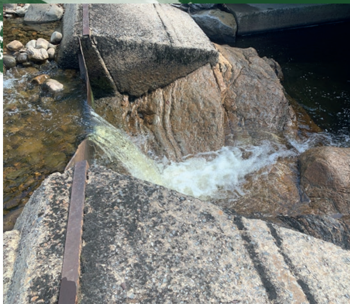
Menneskelige konstruksjoner kan fungere som barrierer for oppstrømsvandring for fisk og andre organismer. Denne er en vannstandsavhengig barriere og kan således virke forsinke og størrelsesselektrende.
