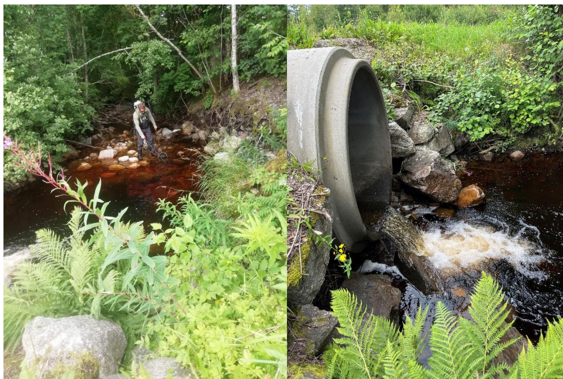
Foto. Øverste stasjon som ble overfisket i Stafsenbekken. Det ble fanget 1 ørret nedstrøms kulverten, som for øvrig er en barriere foruten muligens for stor ørret under høy vannføring (foto: Marius Hassve & Kjell Krogsrud).
