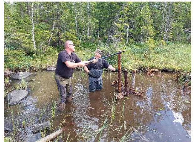
Figur 4. Rotvelter legges ut i myrkulpene og staures fast i sedimentet. Dette gir glimrende skjul for småfisken i de 1-3 åra den lever i bekken.
