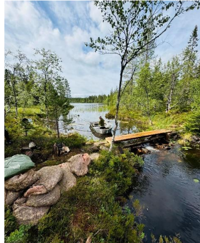
Figur 2. Det var en gammel stokkedam i utløpsbukta, som ble ansett som et vandringshinder. 2-3 cm mellomrom mellom stokkene. Ny bro ble lagt over gammel stokkekonstruksjon.
