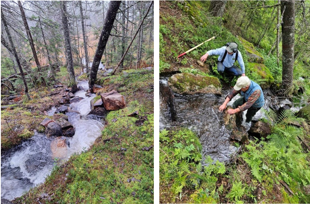
Figur 6. Anlagte sprangkulper og småfusser ned mot Vesle Snellingen. I noen av sprang kulpene ble det lagt ut gytegrus. Gytetfisk har nå mulighet til å kunne vandre opp-/ og nedstrøms.
