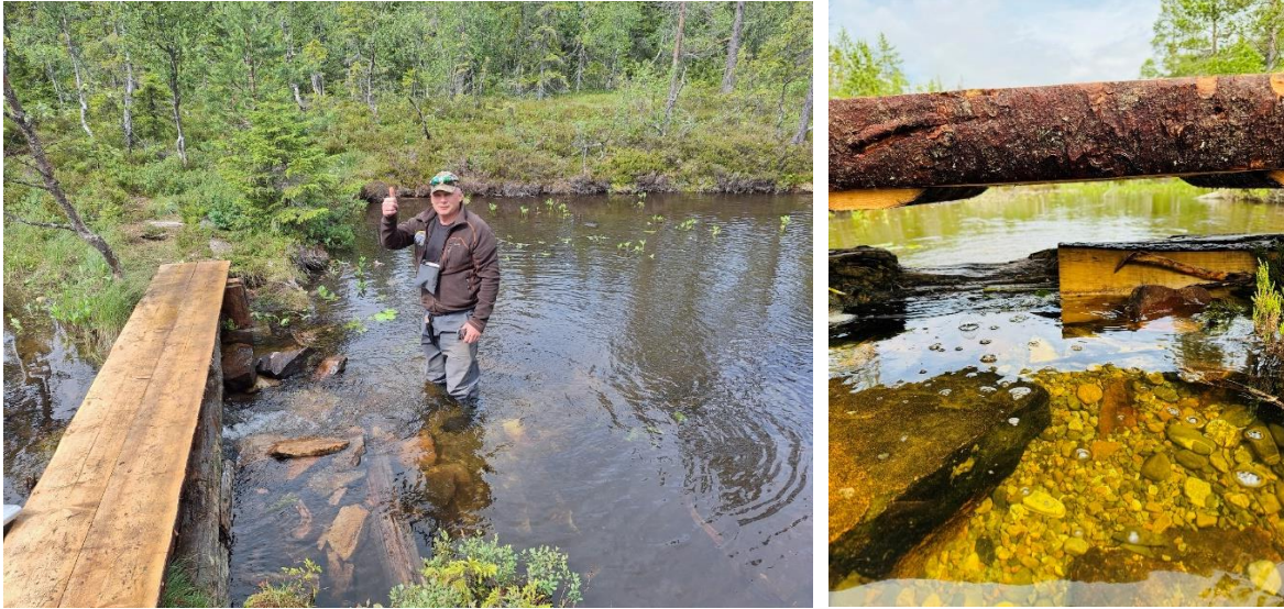
Figur 5. Stokkedammen ved Store Snellingen etter at arbeidet er ferdig. Det er opparbeidet et gytefelt medstrøms.
