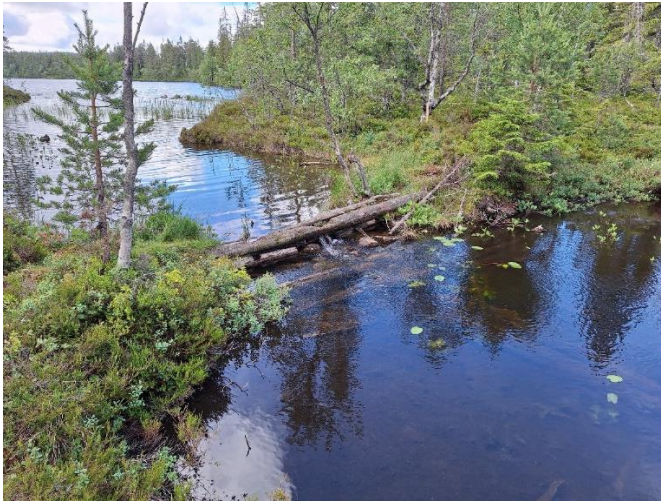
Figur 2. Det var en gammel stokkedam i utløpsbukta, som ble ansett som et vandringshinder. 2-3 cm mellomrom mellom stokkene. Ny bro ble lagt over gammel stokkekonstruksjon.
