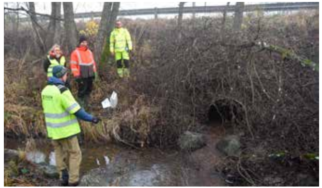
Med fylkeskommunen på befaring av vandringshindre i forbindelse med fylkesveier
