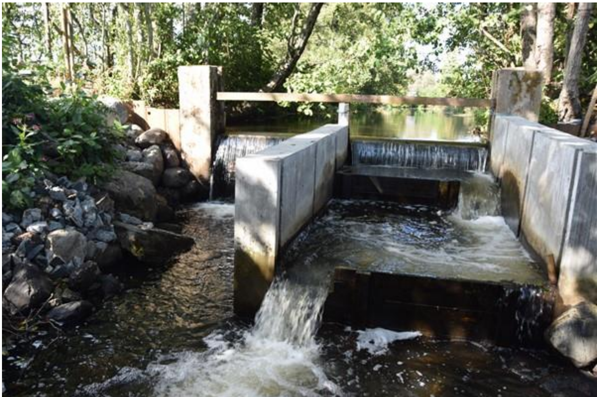
Ferdig utbedret dam ved Søndre Gulland.
