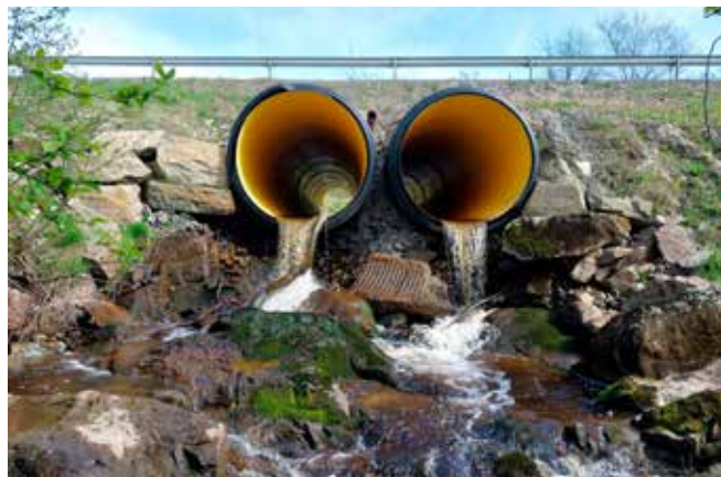
Statens vegvesen har laget et reelt vandringshinder for både vil og fisk - Dørja rv. 22, Indre Østfold.
