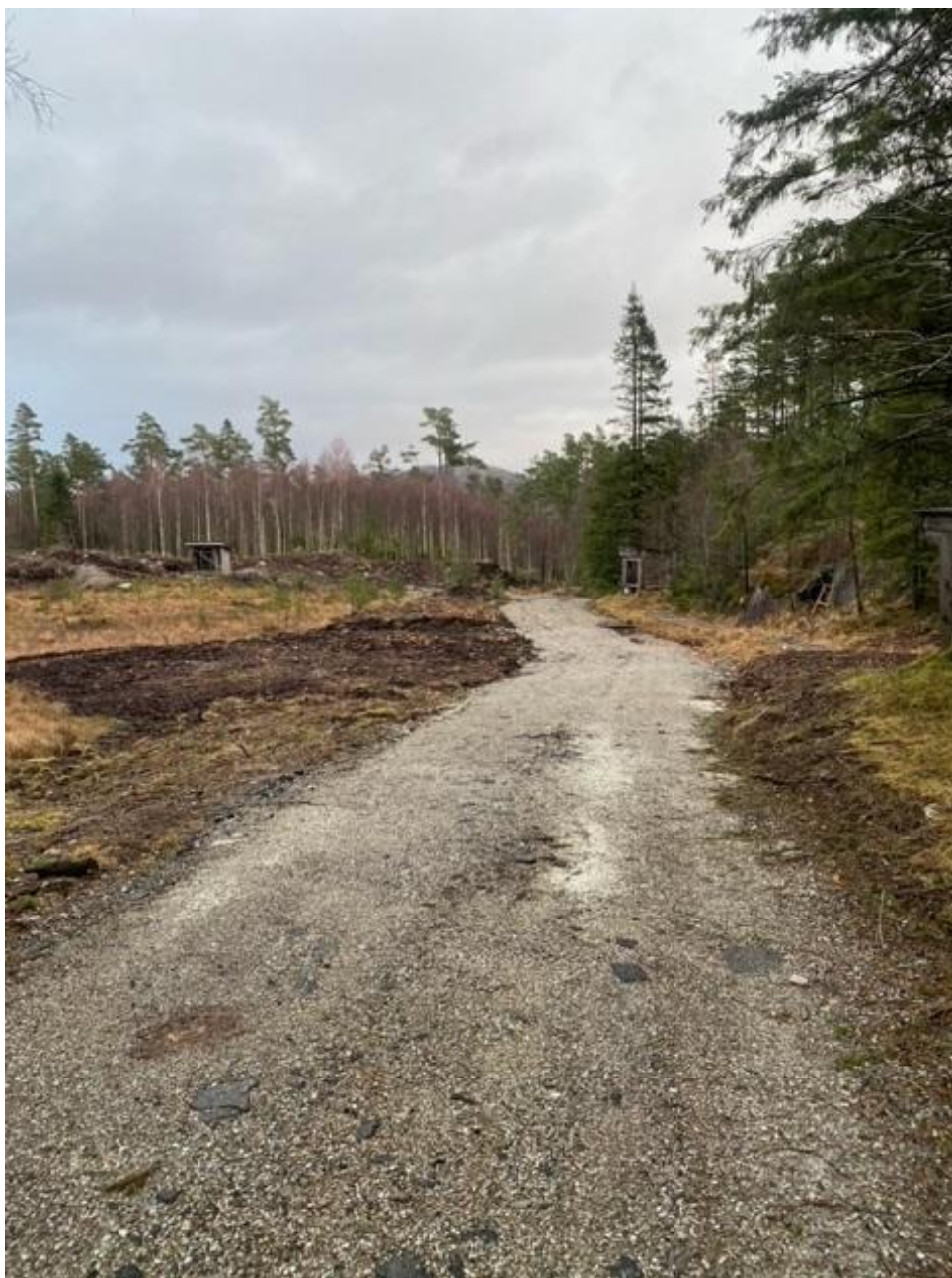
Det er anlagt ny vei på sportingbanen.
