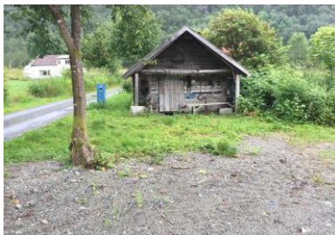
Eldhuset ligger til høyre for hovedbygg.
