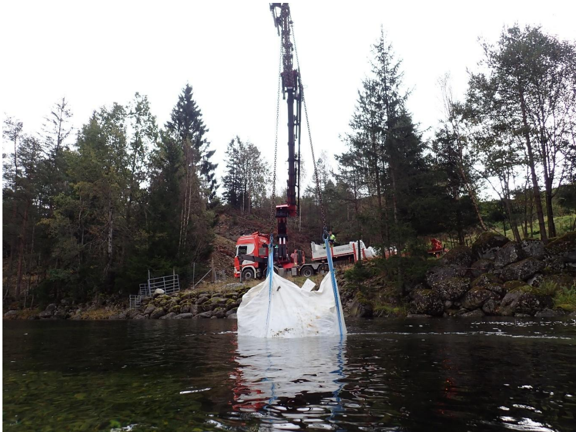
Utlekking av gytegrus ved Sagbogen ved bruk av kranbil og BigBags den 22. september 2025.
