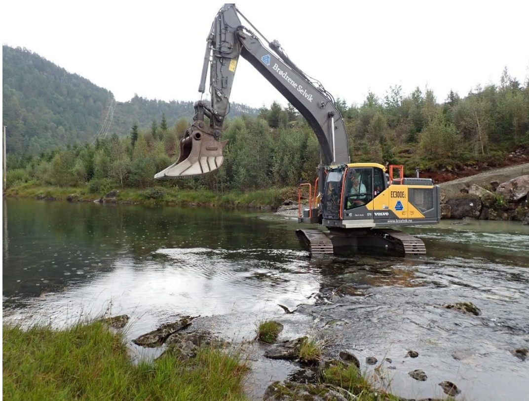
Det ble benyttet gravemaskin samt laget en ny tilkomstrampe for å supplere med gytegrus ved Lona den 27. august 2025.
