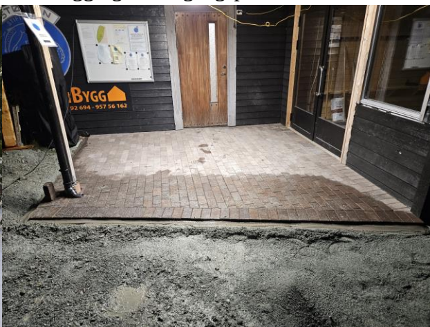
Steinlegging av inngangsparti Bane 1.
